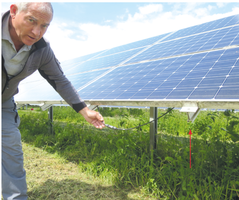
Abb. 20: Karl-Heinz Kempe kontrolliert die Solarparks regelmäßig auf herunterhängende Kabel, damit sich die Tiere nicht darin verfangen. Die überstehende Halterung der Solarmodule (siehe Pfeil) ist scharfkantig und damit ein Verletzungsrisiko. Diese Konstruktionsvariante ist daher nicht zu empfehlen.
